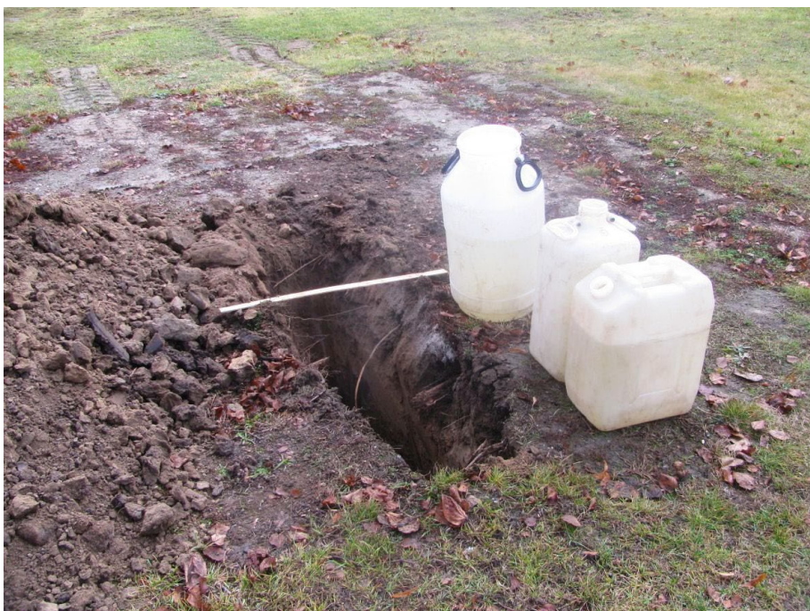
Obr. 3. Realizace vsakovací zkoušky v kopané sondě
