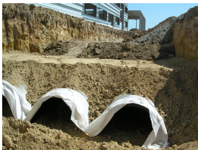
Obr. 8. Vrtné jádro z kaolinických pískovců a vsakovací tunely umístěné v těchto pískovcích
