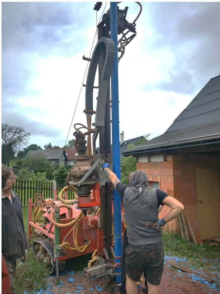
Obr. 4. Nové vystrojování převrtaného vrtu PVC zárubnicemi o průměru 125 mm
