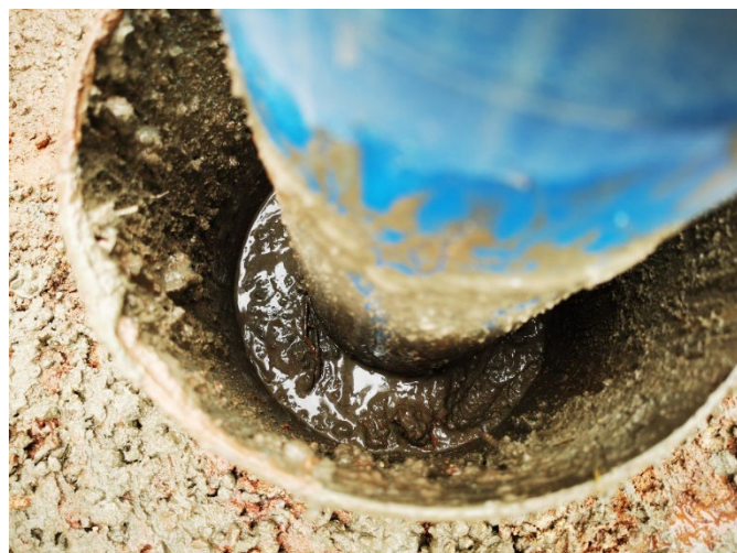
Obr. 7. Cementová směs ve vrtu
