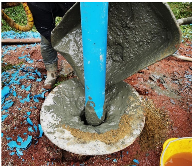
Obr. 6. Cementace vrtu
