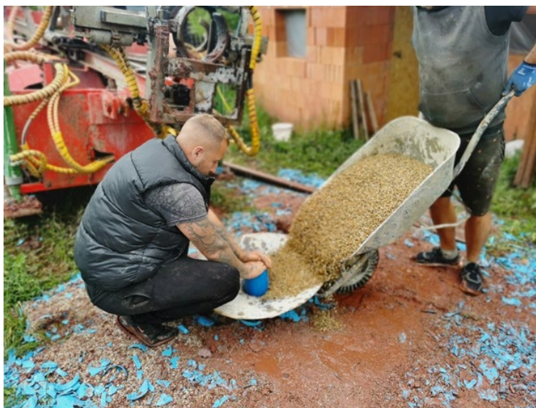
Obr. 5. Obsyp vrtu vodárenským kačirkem frakce 4-8 mm
