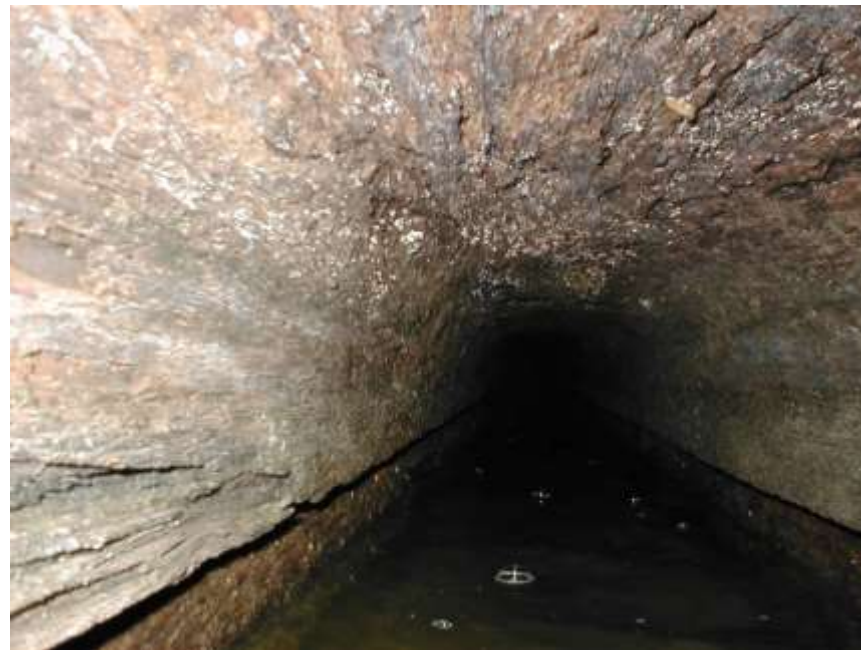
Kamerová prohlídka původního dřevěného potrubí
